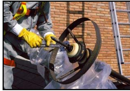
Сл.8 Демонтажа на РАГ и отстранување на вградениот радионуклеид
