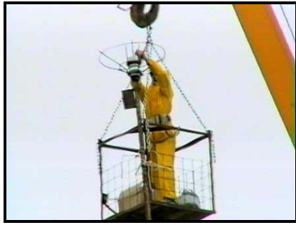
Сл.8 Демонтажа на РАГ и отстранување на вградениот радионуклеид
